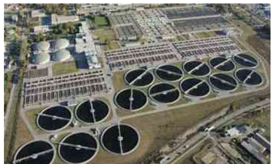
Estação de Tratamento de Esgoto em Viena
